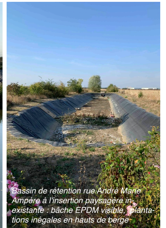
Bassin de rétention à l'angle de la rue Jean Bertin et Albert Caquoi au traitement rude de ses abords : bâche EPDM visible, pas de plantations des berges, clôtures métal en ceinture
